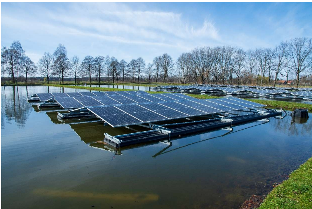
Abb.2: Schwimmende Photovoltaikanlage auf der Versuchsteichanlage in Königwartha (Foto: Dr. Gert Füllner)
